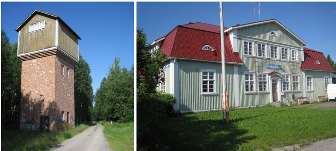
Haapajärven asema-alueen rakennuksia.
